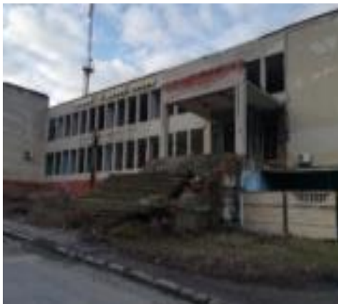
Будівля адміністрації дослідної станції.
